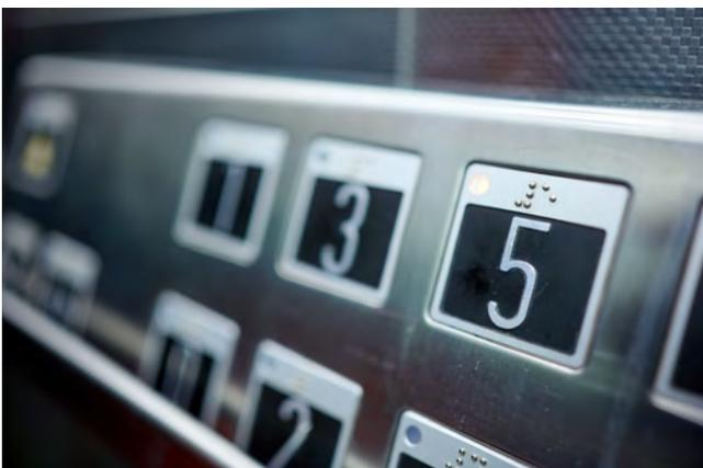
Abbildung 23: Aufzugsnummern mit geritzter Blindenschrift
